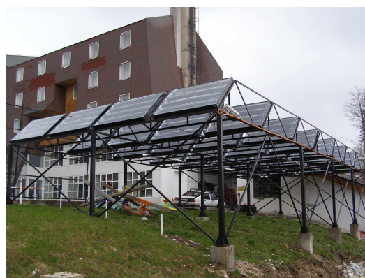
Slika 6 i 7: Solarno termalni kolektori Hotela Maršal (Bjelašnica)
