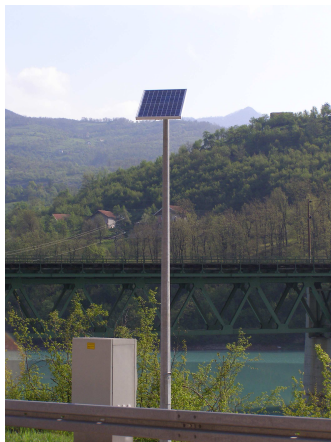
Slika 1 i 2: Samostojni fotonaponski sistemi za praćenje prometa
