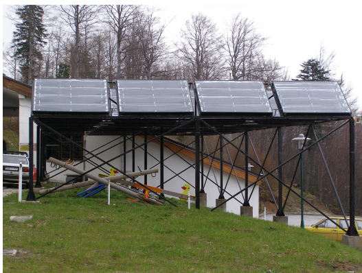
Slika 6 i 7: Solarno termalni kolektori Hotela Maršal (Bjelašnica)
