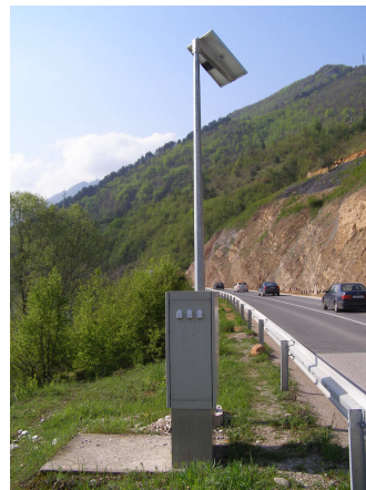
Slika 1 i 2: Samostojni fotonaponski sistemi za praćenje prometa
