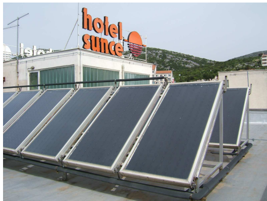
Slika 5: Solarno termalni kolektori na Hotelu Sunce (Neum)
