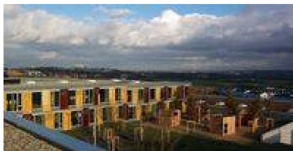
Slika 2.48. Pogled na dvorište
