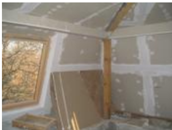
Slika 2.42. Detalj potkrovlja zgrade
