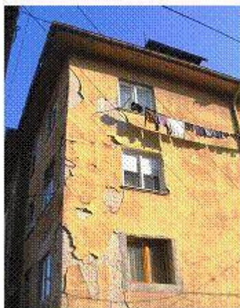
Slika 2.41. Višestambena zgrada u Sofiji izgrađena 1947. godine prije provedbe projekta sanacije
