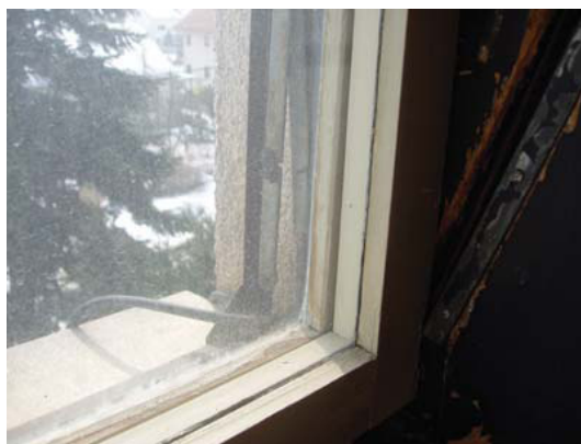
Slika 2.45. Detalj prozora prije rekonstrukcije
