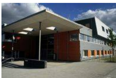
Slika 2.49. Glavni ulaz u školu
