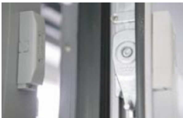
Slika 2.8. Mikroprekidač na prozoru prilikom otvaranja radi ventilacije isključuje sustav grijanja i hlađenja i tako štedi energiju
