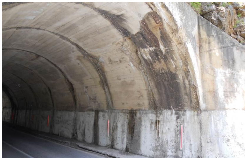
Слика 10 – процуривање облоге тунела
